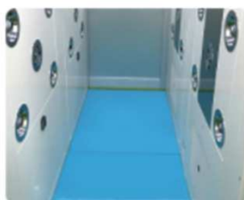
エアシャワー内に敷詰め
